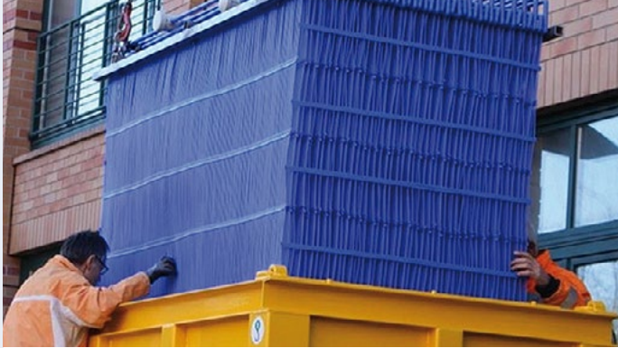
Abb. 18: Hochleistungs-Eisspeicher im Container, mit Kapillarrohrmatte; BEKA Heiz- und Kühlmatten GmbH 2020
