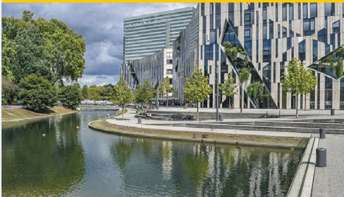
Abb. 37: Künstliche Becken im urbanen Umfeld verbessern das Mikroklima durch Verdunstungskühlung; pixabay
