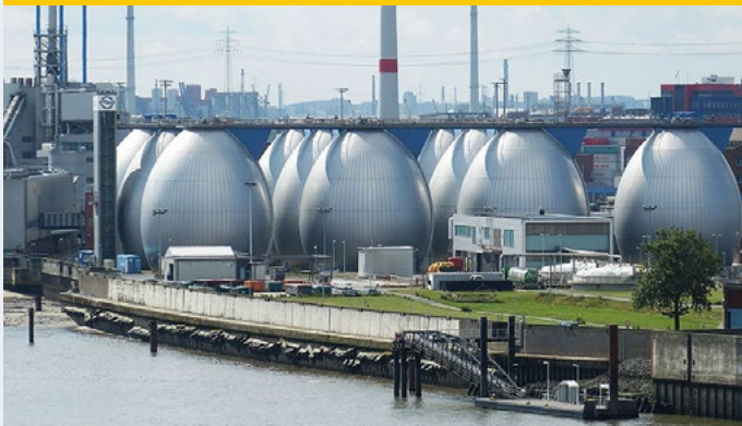
Abb. 32: Falltürme dienen der Faulgasgewinnung und Stabilisierung des Klärschlamm; pixabay
